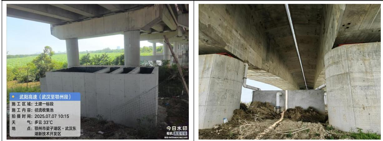
图 9.3-1 桥面径流收集系统设置情况图
